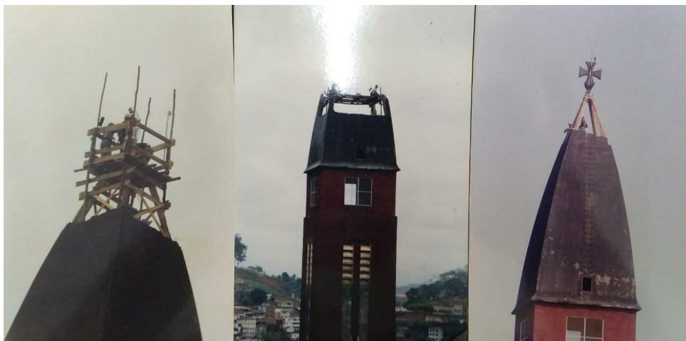
Imagem 12: Torre da Igreja de São José em construção
