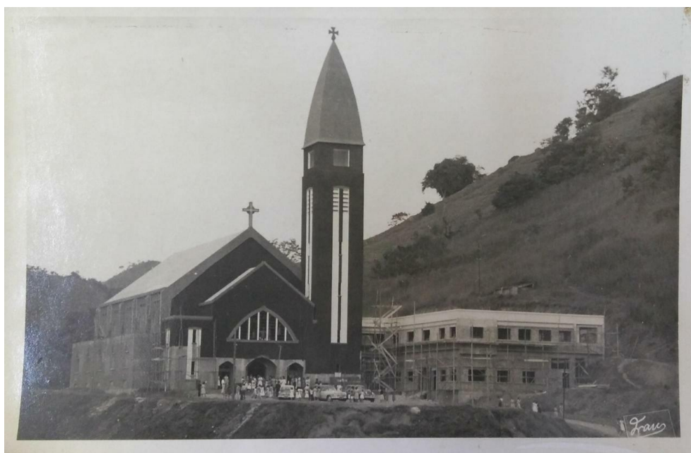
Imagem 13 – Visão da Igreja de São José – com o convento em anexo.
