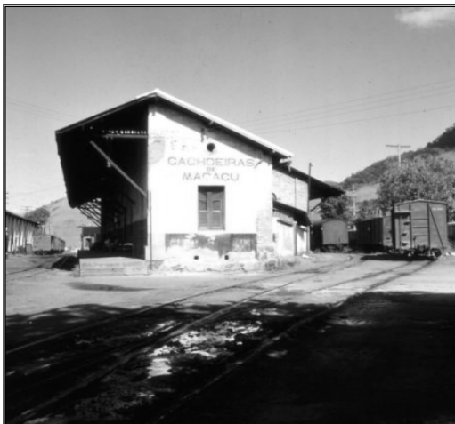
Figura 1: Símbolo da decadência - Estação de Cachoeiras demolida no início dos anos 1970
